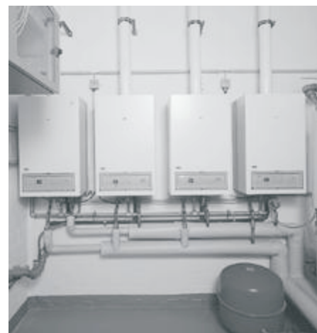
Kotły grzejne w konfiguracji kaskadowej.
